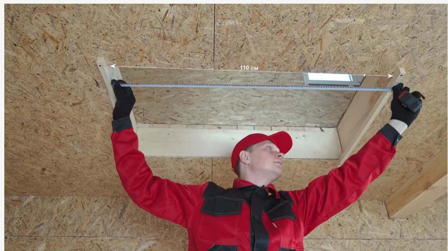
Нужно заметить: при таком способе монтажа нам удастся выровнять низ короба с плоскостью потолка. При этом крышка люка будет выступать от потолка на 14 мм. Так что если вы хотите смонтировать крышку заподлицо с потолком – подложите что-то на вспомогательные планки и не забудьте проверить их уровень.
