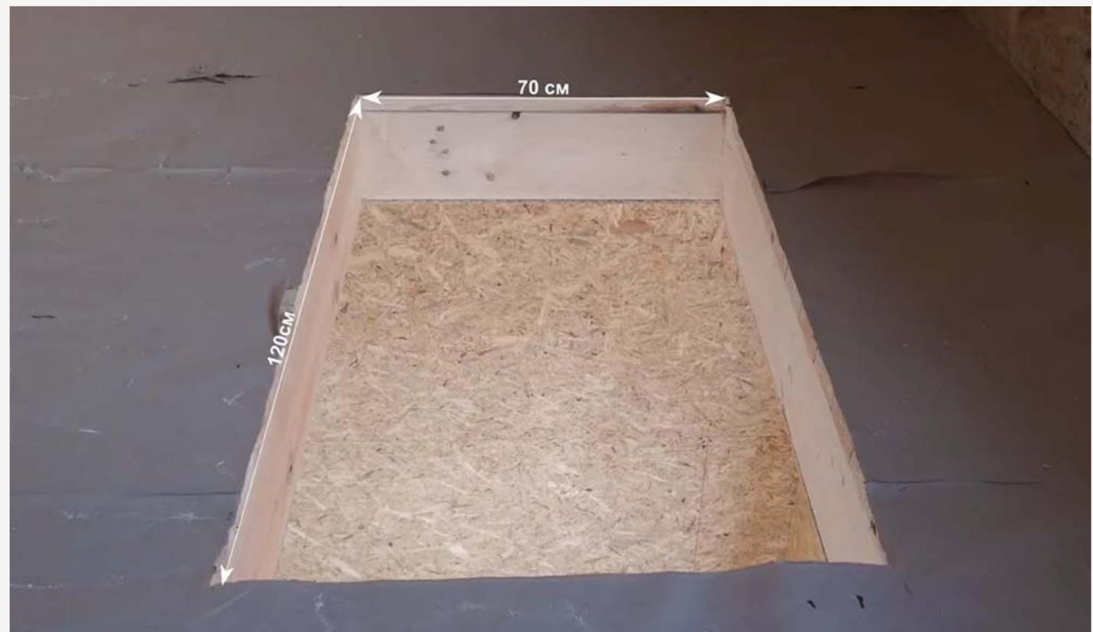
Сам проем не должен располагаться впритык к стенам или мебели. Нужно учитывать радиус раскрытия лестницы, в нашем случае он составляет 1 метр 64 сантиметра. С задней стороны лестницы мы рекомендуем делать отступ от стены до проема минимум в 10 сантиметров, чтобы крышка люка шириной 80 мм беспрепятственно открывалась до конца.
