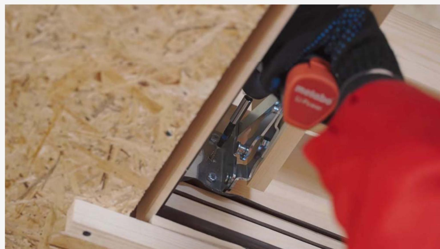
После этого можно выкрутить вспомогательные планки, они нам больше не понадобятся. Опускаем нашу лестницу и вставляем по 3 приставки с каждой длинной стороны короба. Еще раз промеряем диагонали рулеткой и углы угольником.... Если диагонали совпадают и в углах нет зазоров, значит все в порядке. Окончательно расклиниваем короб через приставки – по 3 самореза с каждой стороны.
