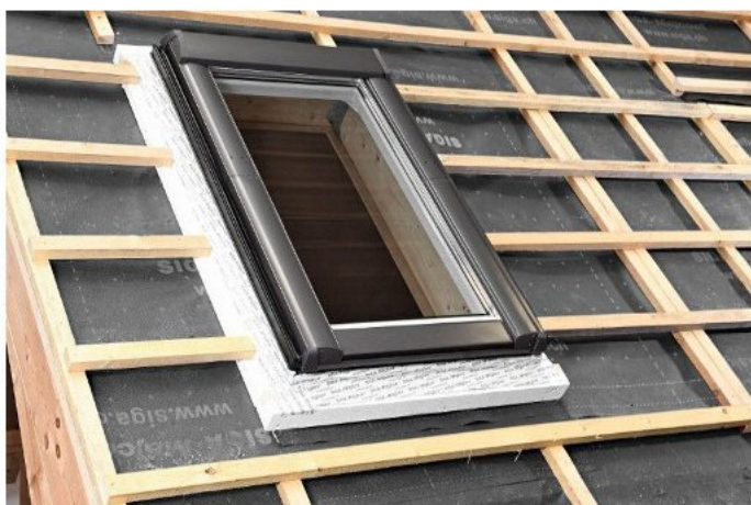
Рама MDA установлена на гидроизоляцию кровли.
