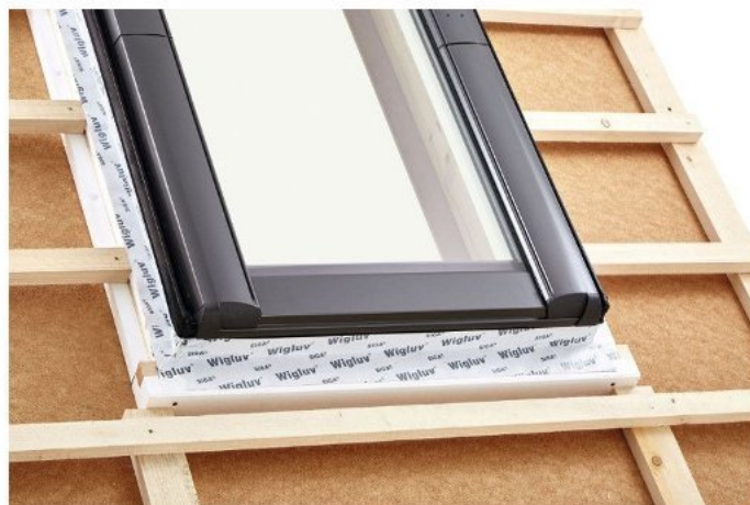
Рама MDA установлена на сплошной настил.
